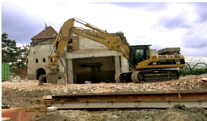
Nedrivning af elefanthuset og anlægsarbejde i den arktiske ring i Zoo
